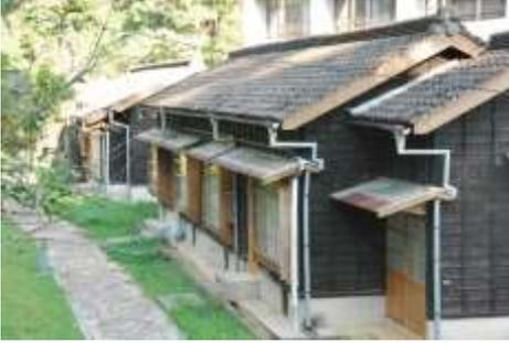
建物は檜が主材料で建てられた日本式建築で、瓦造りの屋根が日本古風な外観、内部には竹筋が採用されており、室内が適度に乾燥する造りになっています。
